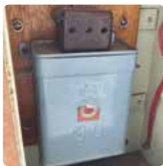
電力用コンデンサー
