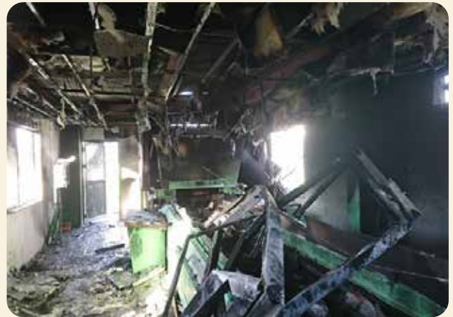
リチウムイオン電池の発火が原因で、リサイクル工場の建屋・設備が焼けてしまった事例
